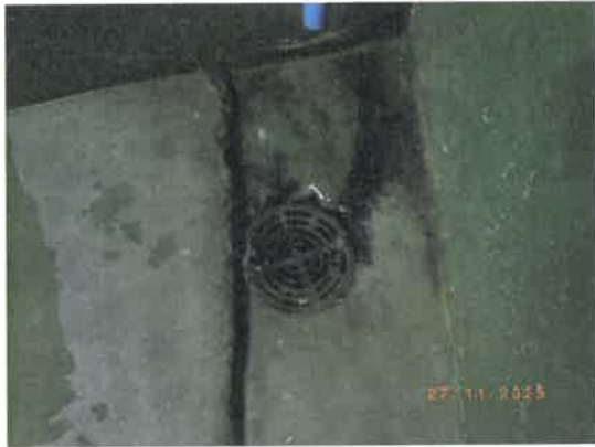
รูปที่ 2-17 ท่อรวมน้ำทิ้งในห้องพักผ่อนแต่ละประเภท
